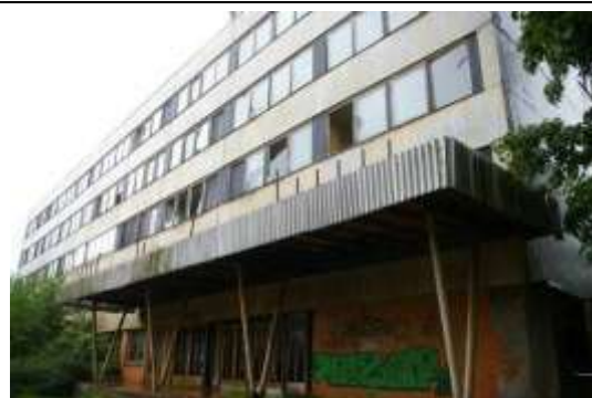
Administratīvā ēka ar kadastra apzīmējumu 1700 010 0064 001
