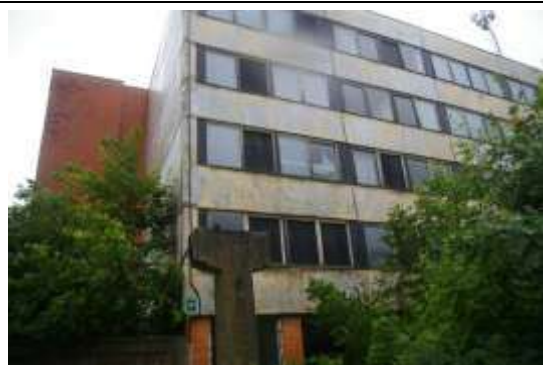
Administratīvā ēka ar kadastra apzīmējumu 1700 010 0064 001
