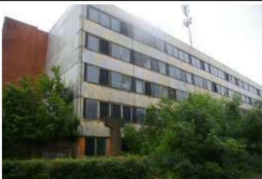
Administratīvā ēka ar kadastra apzīmējumu 1700 010 0064 001
