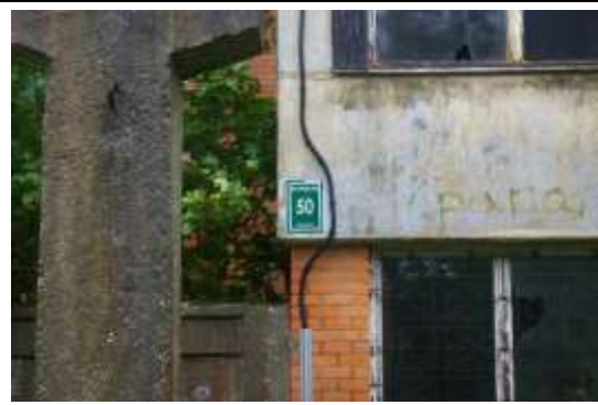
Administratīvā ēka ar kadastra apzīmējumu 1700 010 0064 001
