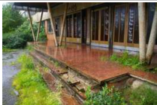
Administratīvā ēka ar kadastra apzīmējumu 1700 010 0064 001
