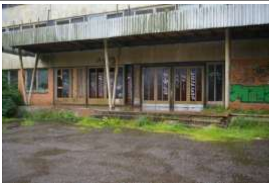
Administratīvā ēka ar kadastra apzīmējumu 1700 010 0064 001
