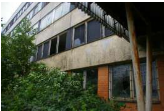
Administratīvā ēka ar kadastra apzīmējumu 1700 010 0064 001
