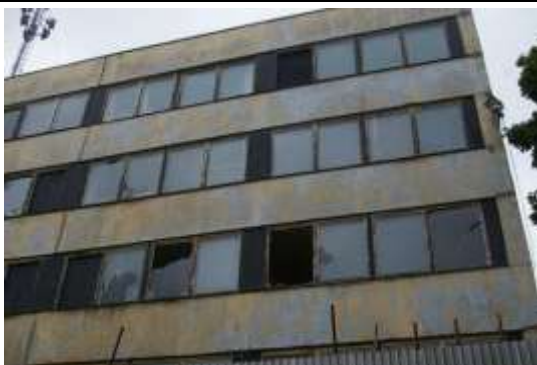
Administratīvā ēka ar kadastra apzīmējumu 1700 010 0064 001
