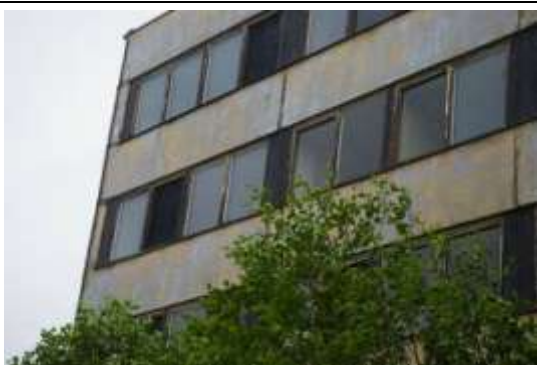
Administratīvā ēka ar kadastra apzīmējumu 1700 010 0064 001
