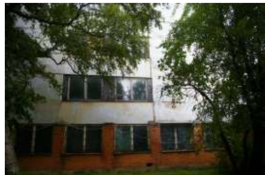
Administratīvā ēka ar kadastra apzīmējumu 1700 010 0064 001
