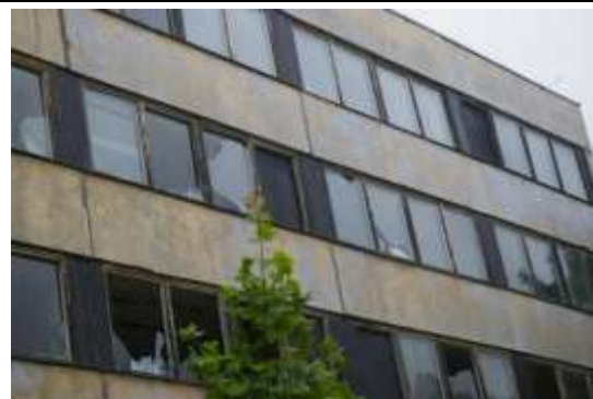
Administratīvā ēka ar kadastra apzīmējumu 1700 010 0064 001
